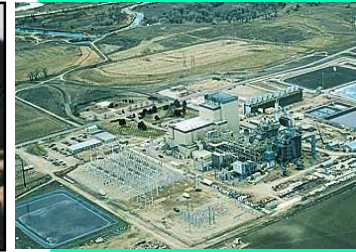
Fort Saint-Vrain, US 300 MWe, 1976-89
